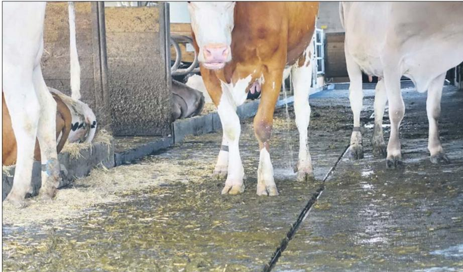
3D-Gummiaufgabe mit Gefälle zur Harnrinne in einem Rindviehstall. Rascher Harnabfluss reduziert die Ammoniakbelastung markant.
