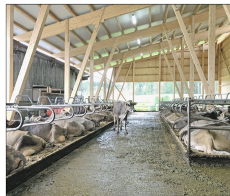
Auch bei den Liegeboxen wird stündlich mit dem Roboter gereinigt und der Harn kann seitlich abfließen.
