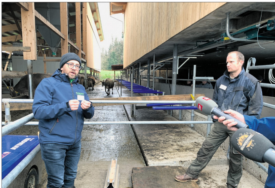
Baucoach Erich von Ah (links) und Betriebsleiter Roman Zimmermann erläutern den Medienleuten die Besonderheiten des neuen Stalles. Mit seitlicher Harnrinne, erhöhtem Fressplatz und stündlich laufendem Entmistungsroboter. (Bilder Josef Scherer)
