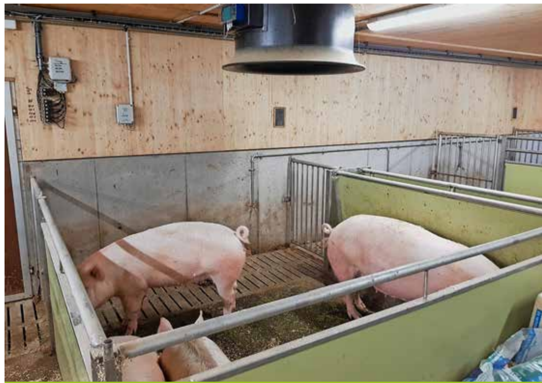
Le flux d'air est conduit sous les animaux dans la porcherie puis il est aspiré par la cheminée. La chaleur corporelle des animaux équilibre la température de la stabulation. MICHEL FISCHLER
