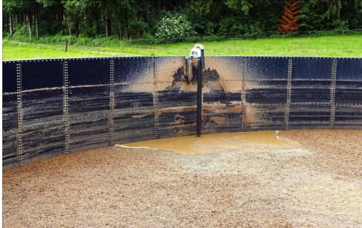
Das Befüllen des Behälters von oben verhindert die Bildung einer intakten Schwimmschicht.
