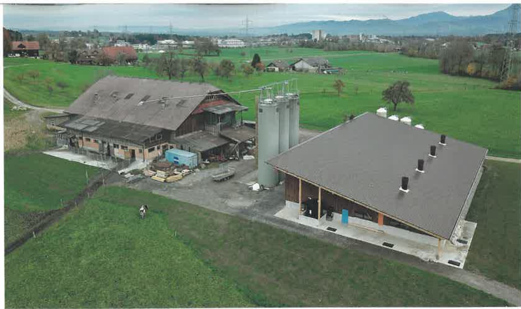
▷ Blick von oben: Beim Gülleensäuerungssystem ist von aussen vor allem der schwarze Säuretank am Schweinestall zu erkennen.
