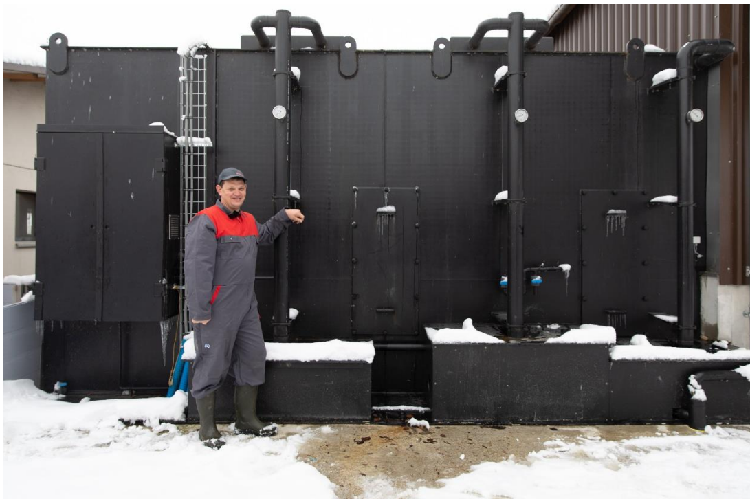
Kaspar Sigrist vor seinem dreistufigen Biowäscher, der Staub, Ammoniak und Geruch aus der Stallabluft entfernt. Bild Monique Wittwer.
