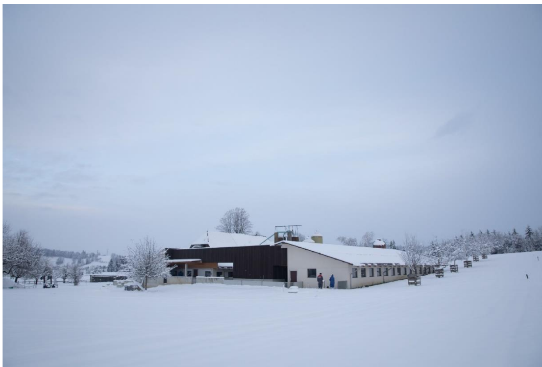
Vue extérieure de la porcherie Sigrist. L'ancienne porcherie (à gauche, façade sombre) a été transformée en porcherie de mise bas. La nouvelle annexe (à droite, façade claire) sert de porcherie pour gorettes.
