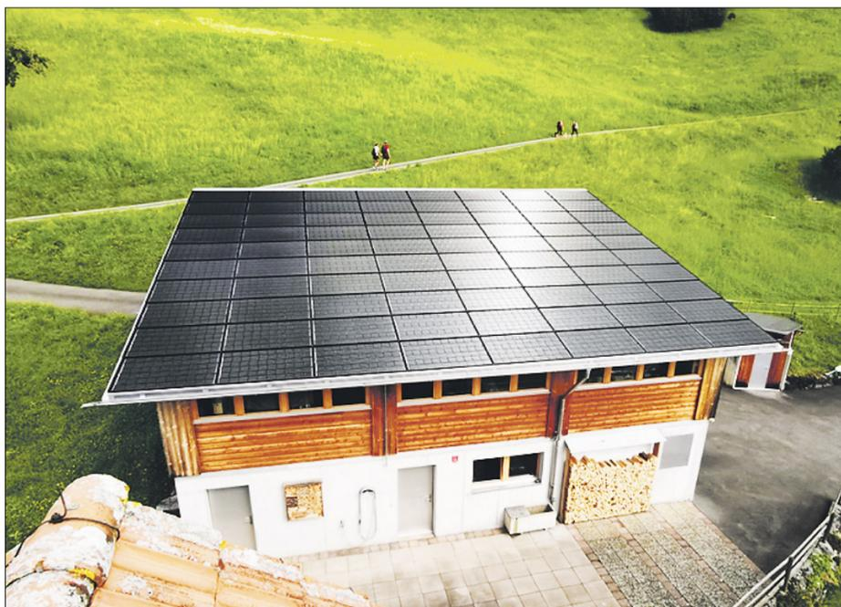
Mit Solaredge leistungsoptimierte Module auf dem 140 m<sup>2</sup> grossen Dach des Ökonomiegebäudes von Josef Küng. Im Untergeschoss stehen ein Batteriespeicher und ein Elektroauto. (Bild Helion)
