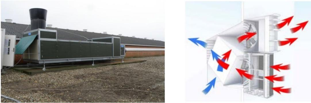
Abbildung 1: Links: Wärmetauscher (Quelle: VERA, 2019). Rechts: Schema des Funktionsprinzips des Wärmetauschers mit der warmen Abluft (rote Pfeile), welche die kalte Zuluft (blaue Pfeile) erwärmt und umgekehrt (Quelle: [RINAUEN\\_Gefluegelmaststall\\_interaktiv\\_12\\_21-1.pdf](#), 08.05.2023).
