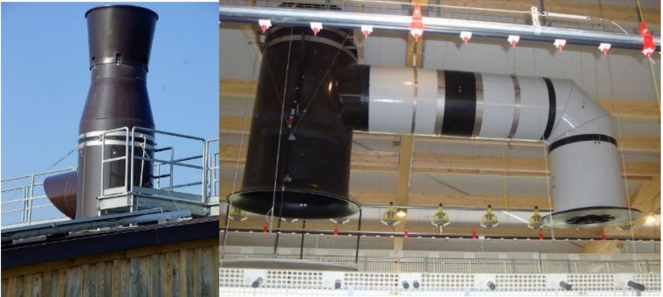
Abbildung 2: Rohrbündel-Wärmetauscher, Aussen- und Innenansicht des Minergie-A/P Geflügelstalls (Van Caenegem et al. 2020).
