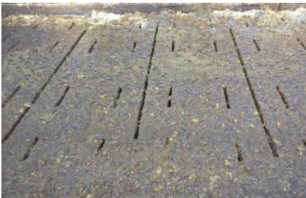
Abbildung 6: Perforierter Boden mit reduziertem Schlitzanteil untersucht von Kai et al. (2017) (Quelle: Kai et al. (2017), S. 9).
