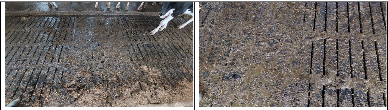
Abbildung 10: MeadowFloor mit Dichtungsklappen in der Mitte (Bild links) und auf der linken Hälfte des Bodens (Bild rechts) (Quelle: Michael Schwarzenberger, Arenenberg, 14.09.2022).
