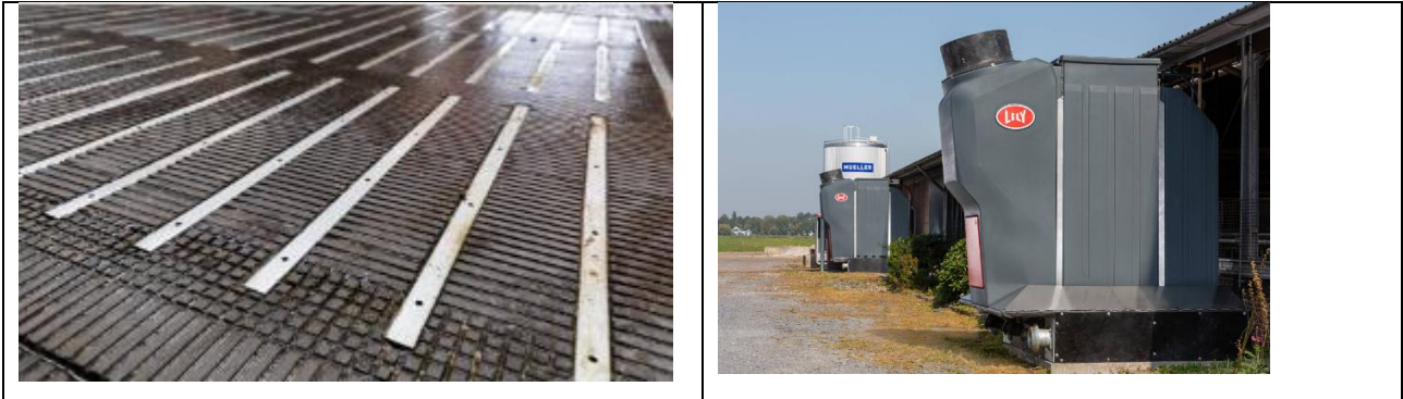
Abbildung 1. Links: System zur Trennung von Kot und Harn auf der Lauffläche. Der Harn wird durch die Löcher der Metalleinlagen, die in den Schlitzen der Spaltenböden angebracht sind, abgeleitet (Quelle: Lely Sphere - Mistverarbeitungssystem - Lely , 27.07.2023). Rechts: Chemowäscher (Lely Sphere N-Capture; Quelle: Lely Sphere - Mistverarbeitungssystem - Lely , 27.07.2023)
