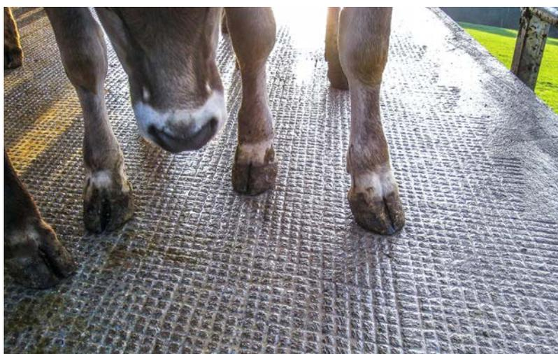
Rainurage longitudinal et transversal d'une surface plane : afin d'éviter toute blessure aux onglons, il ne doit y avoir aucune cassure. Photo: bm-agrotech
