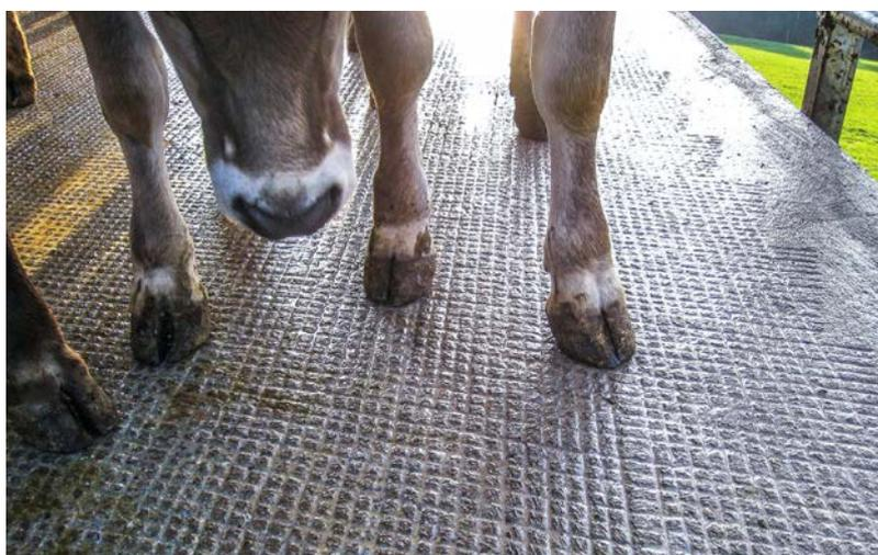
Längs- und Querrillierung einer planbefestigten Fläche: Um Klauenverletzungen zu vermeiden, dürfen keine Ausbrechungen entstehen. Bild: bm-agrotech
