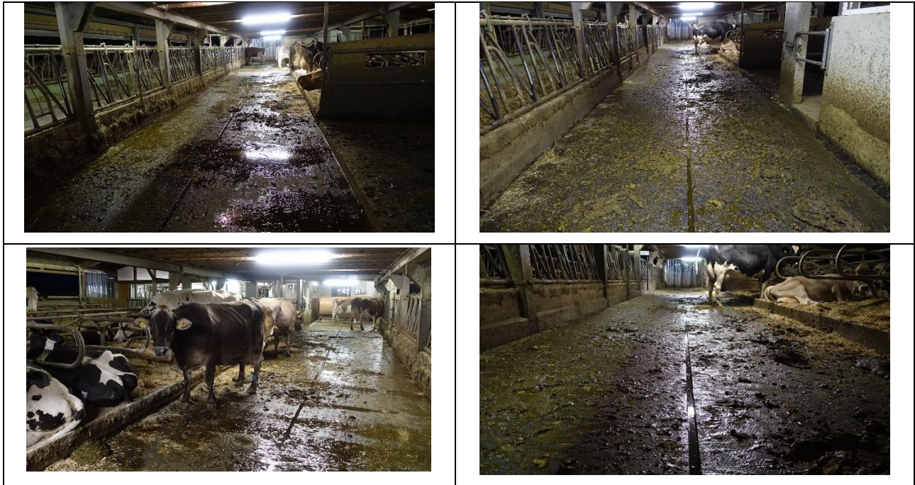
Abbildung 3: Bilder vom Betrieb Hohenrain. Links vor dem Umbau: Standardmatte ohne Gefälle, rechts nach dem Umbau: profiKURA-3D-Gummimatte mit 3 Prozent Quergefälle (Quelle: Markus Bucheli, Hohenrain).
