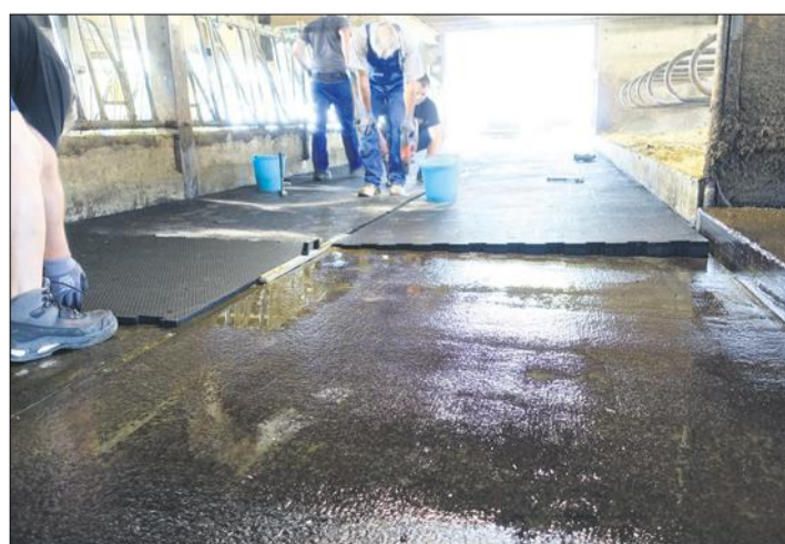
Montage der Gummimatten über den alten Bodenbelag vergangene Woche in Hohenrain.
