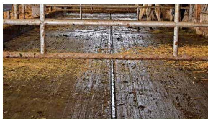
Une pente transversale de 3% et une rigole de collecte des urines diminuent les émissions d'ammoniac. V. GREMAUD
