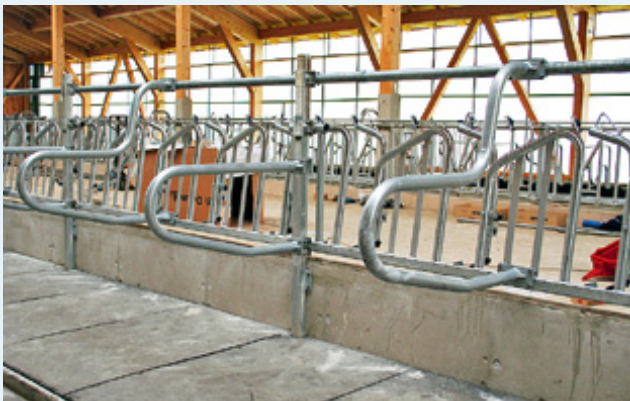
Erhöhter Fressplatz mit Gummiauflage und Pilzbügel: Die Bügel sollen den Kühen mehr Ruhe beim Fressen geben.
